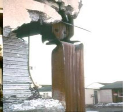
Fallo frágil debido al cortante y tensión diagonal en columnas y vigas.
