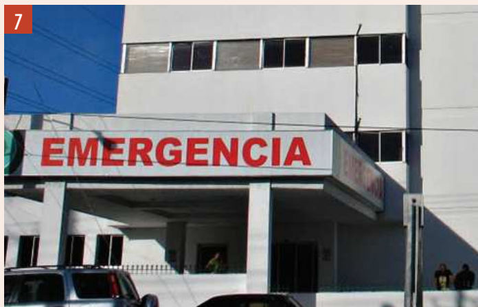
Imagen 6. Hospital Central de las Fuerzas Armadas, efecto de columnas cortas.
