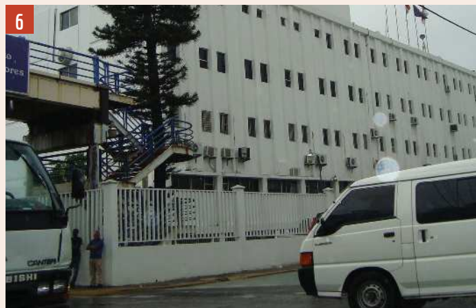
Imagen 5. Hospital de las Fuerzas Armadas, efecto piso suave.
