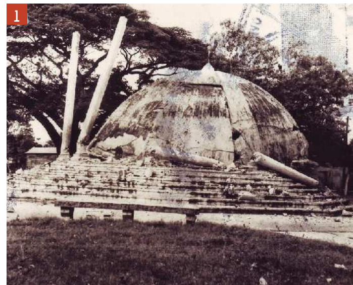
Imagen 1. Colapso glorieta del parque de Moca en el Terremoto del 4 de agosto de 1946.
