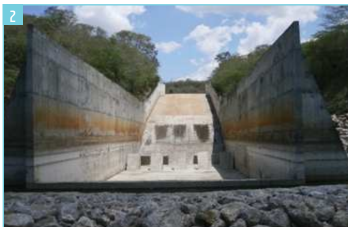
Imagen 2. Vista Frontal del Cuenco Dissipador de la Presa de Chacüey.
