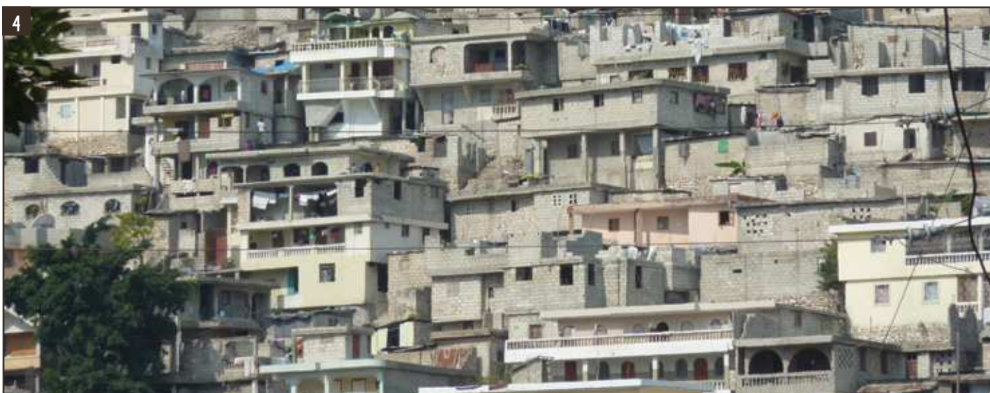
Imagen 4. Viviendas pobres intactas, levantadas sobre roca caliza en el eje de la falla del sismo de Haití, al suroeste de Petion Ville.
