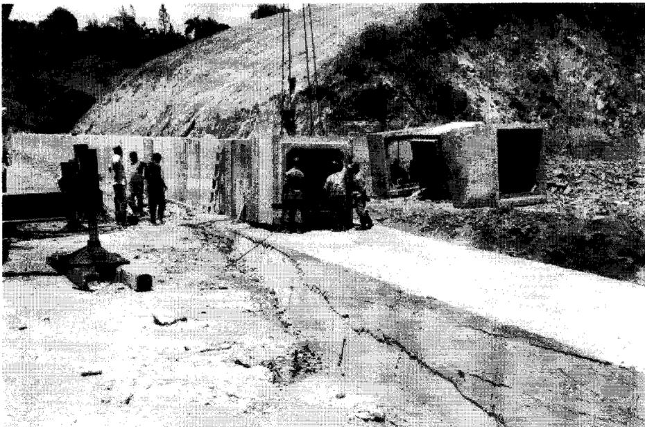
ALCANTARILLA DE CAJÓN PREFABRICADO
