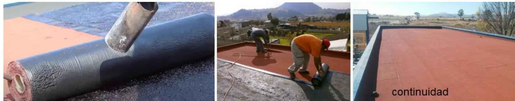
Las impermeabilizaciones deben garantizar que las capas queden firmemente adheridas entre sí.
