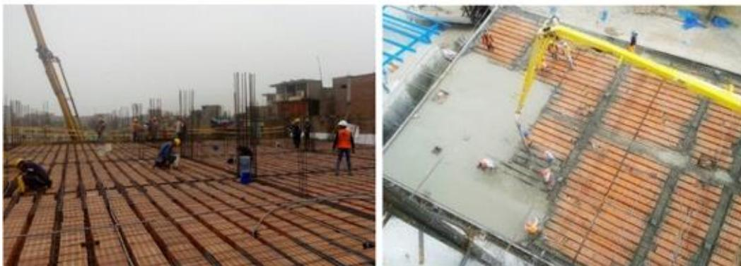
Losas de casetones o nervadas en dos direcciones: Bidireccionales
