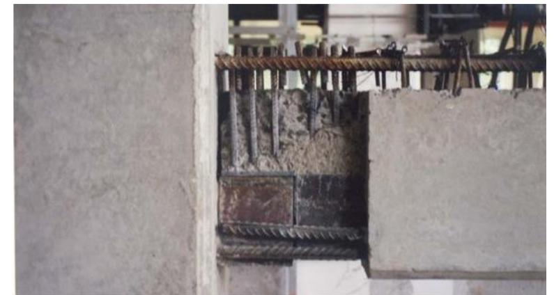
Conexión de viga y columna: placas soldadas embebidas en concreto
