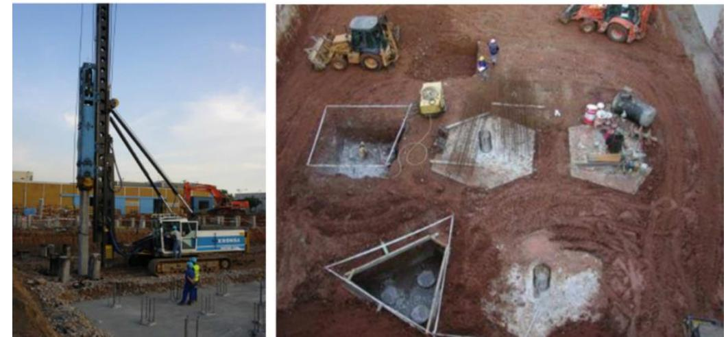
Pilotes prefabricados de hormigón, de sección cuadrada clavados por hincadora
