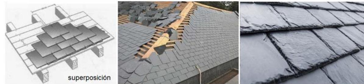
La cubierta de pizarra natural se forma por superposición de elementos planos, independientes unos de otros, que se recubren parcialmente entre sí
