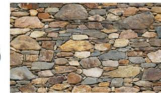
**Sillarejo:** Sillar pequeño, labrado toscamente, que no atraviesa todo el grosor del muro
