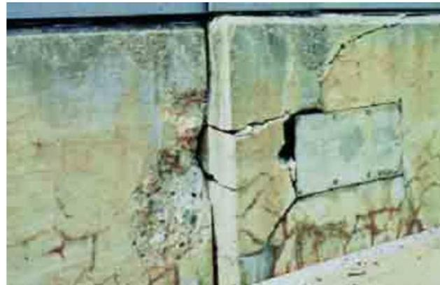
Fisuración causada por la severa reactividad álcali-agregado en este muro.
