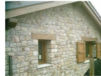
**Arenisca**, piedra compuesta de arena cementada. Es un material de construcción usado como elemento arquitectónico y decorativo (para la creación de muros o el revestimiento de fachadas). Las areniscas se utilizan principalmente para pavimentar suelos gracias a su dureza y a la gran disponibilidad de modelos y colores. La piedras pequeña, redondeadas y lisas también se utilizan para hacer hormigón.
