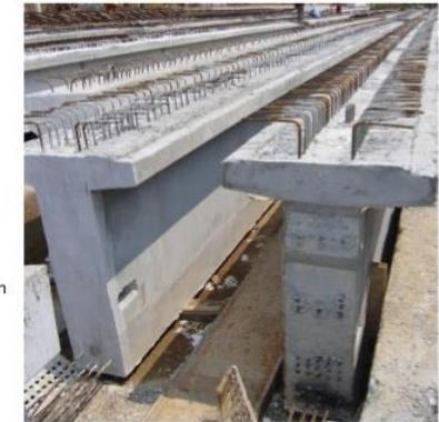
Los elementos de concreto pretensado son sometidos intencionalmente a esfuerzos de tensión compresión previos a su puesta en servicio con el objetivo de aumentar su resistencia.
