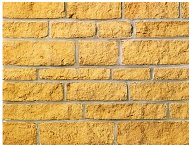
Revestimiento de muro con piedra caliza
