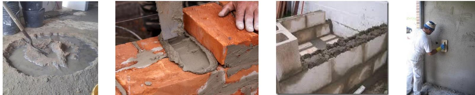
**Mortero monocapa**, es un mortero prefabricado constituido por cemento y/o cal, áridos, pigmentos minerales y coloreado en masa mediante aditivos orgánicos, listo para ser amasado con agua.
