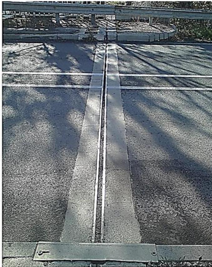
**Junta de dilatación de un Puente**
