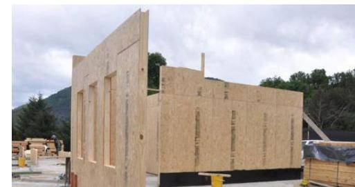
**OSB** (*Oriented strand board* (**OSB**), es un tipo de madera conglomerada, tablero de virutas o astillas de madera, orientadas en una misma dirección. Los OSB se utilizan tanto en revestimientos finales y mobiliario como en estructura. Se utilizan como "alma" en vigas mixtas o de madera, como tableros de soporte de la cubierta, como base de suelos, como tabiquería en paredes, y también formando parte de algunos tipos de "panel sándwich".
