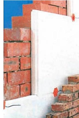
**Poliestireno expandido** material de relleno de buen aislamiento térmico.
