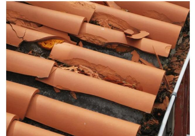
Efecto de los ciclos de hielo / deshielo en una cubierta de tejas cerámicas
