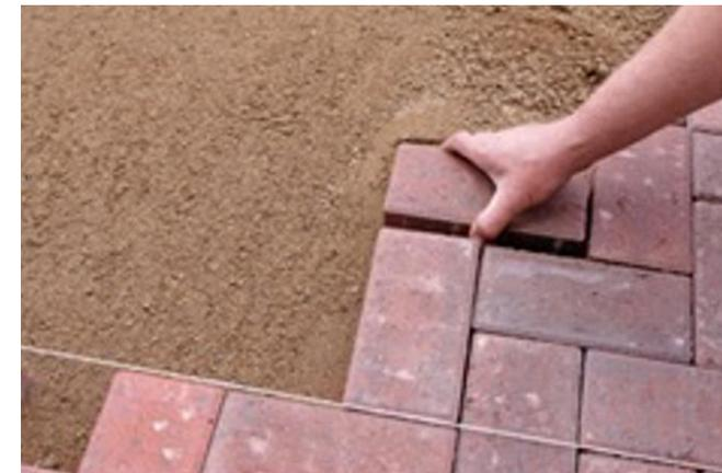
Para uso en forjados, los adoquines cerámicos se colocarán bien sobre una capa de arena de 3 a 5 cm de espesor o sobre una capa adhesiva (cemento cola).
