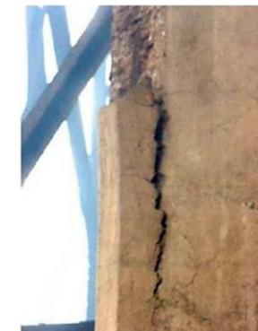
Astillamiento-desprendimiento en pilar de concreto
