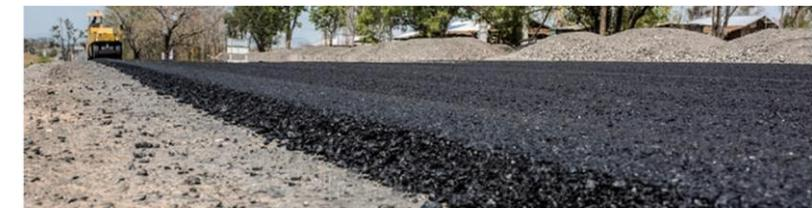
El asfalto, también denominado betún, es un material viscoso, pegajoso y de color plomo. Se utiliza mezclado con arena o gravilla para pavimentar caminos y como revestimiento impermeabilizante de muros y tejados.
