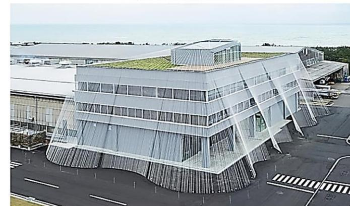
En Japón han fabricado una fibra de carbono termoplástica llamada CABKOMA Strand Rod, cual está cubierta con fibras sintéticas e inorgánicas, revestida con una resina termoplástica.
