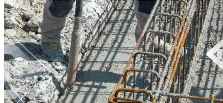
Encofrado y desencofrado de jácenas con tableros de madera de pino de 22 mm. confeccionados previamente, considerando 4 posturas. Normas NTE-EME.
